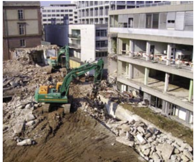
Abbruch des alten Frauenspitals – Aufnahme vom Mai 2007.
